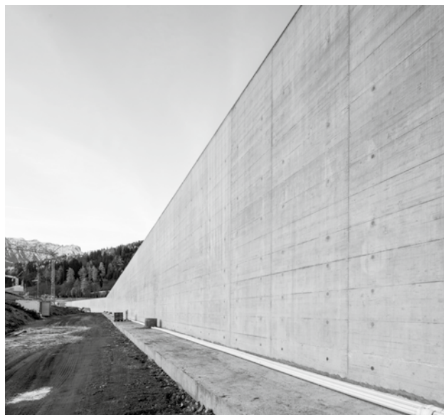
Umfassungsmauer JVA Realta
